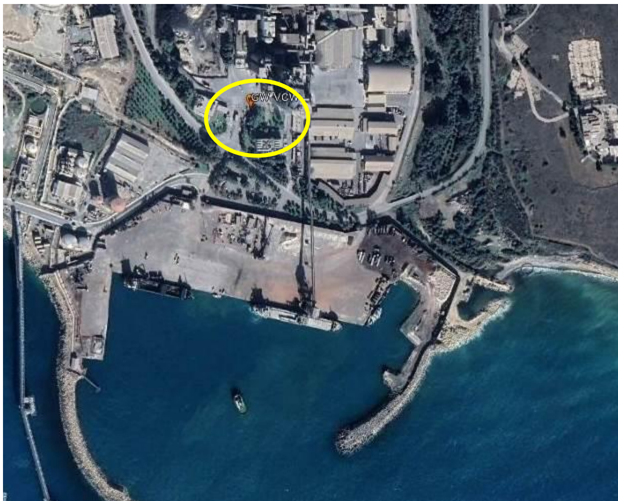
Εικόνα 10: Θέση δειγματοληψίας νερού από τον υπόγειο υδροφορέα (GW VCW)
