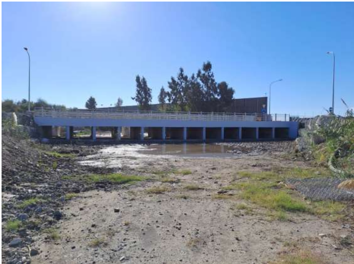
Εικόνα 3-1: Αρχική γέφυρα – ανάντη πλευρά (φωτογραφία περιοχής)
