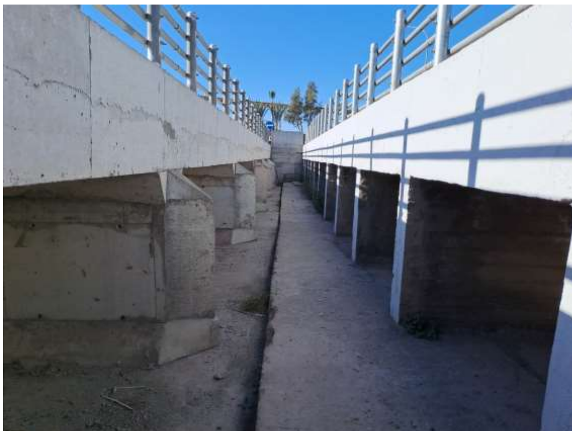
Εικόνα 3-3: Νέα γέφυρα (αριστερά) – Αρχική γέφυρα (δεξιά) (φωτογραφία περιοχής)
