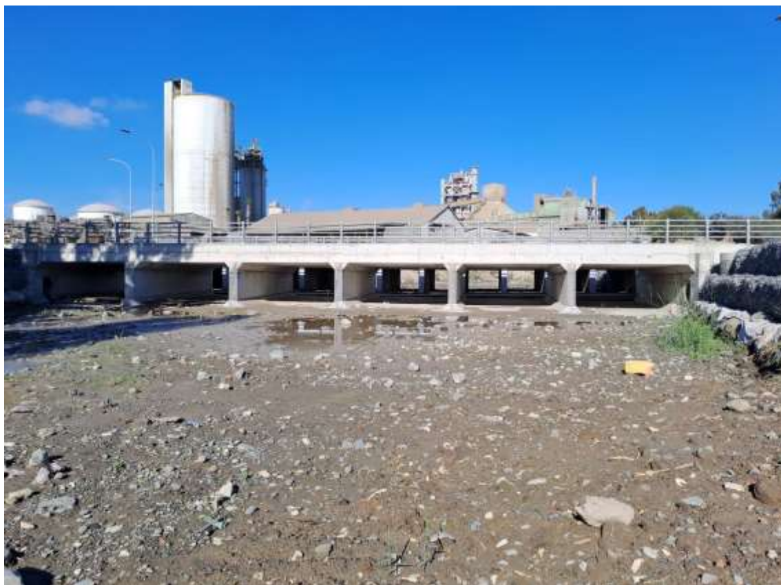
Εικόνα 3-2: Νέα γέφυρα – κατάντη πλευρά (φωτογραφία περιοχής)
