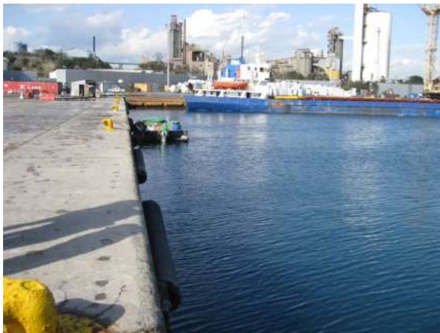
Εικόνα 11.5: Δυτικά κρηπιδώματα Λιμένα Βασιλικού. Διακρίνεται ο λιμενικός εξοπλισμός (Δέστρες, κυλινδρικοί προσκρουστήρες).
